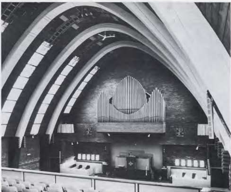
19. Het interieur van de kerk in Appingedam: parabolische dakspanten, het orgel als onderdeel van de architectuur.
