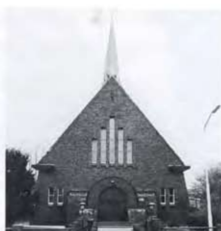
28. De kerk van Westeremden, gebouwd door Albert Wiersema, 1934. Zorgvuldig vormgegeven voorgevel.
