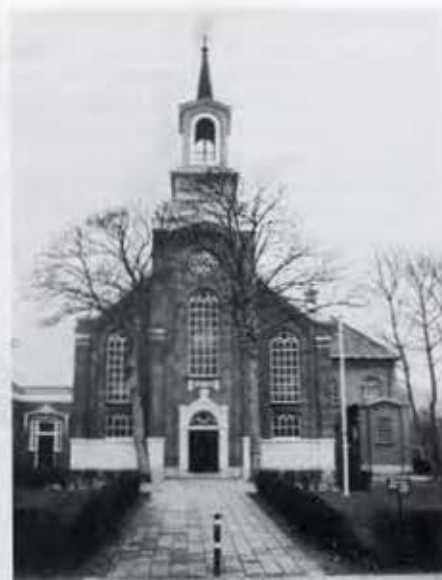
17. De voorgevel van de nieuwe kerk van Middelstum, 1870.
