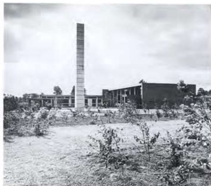
59. De Christelijke Gereformeerde kerk in Stadskanaal in oorspronkelijke gedaante: rechts de kerk, links de dienstvertrekken; obelisk van beton.
