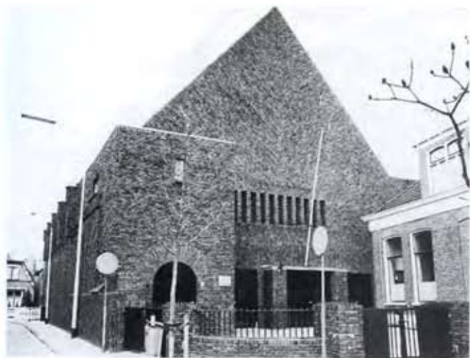
16. Voorgevel van de kerk in Appingedam (1928) met verschillende metselpatronen.
