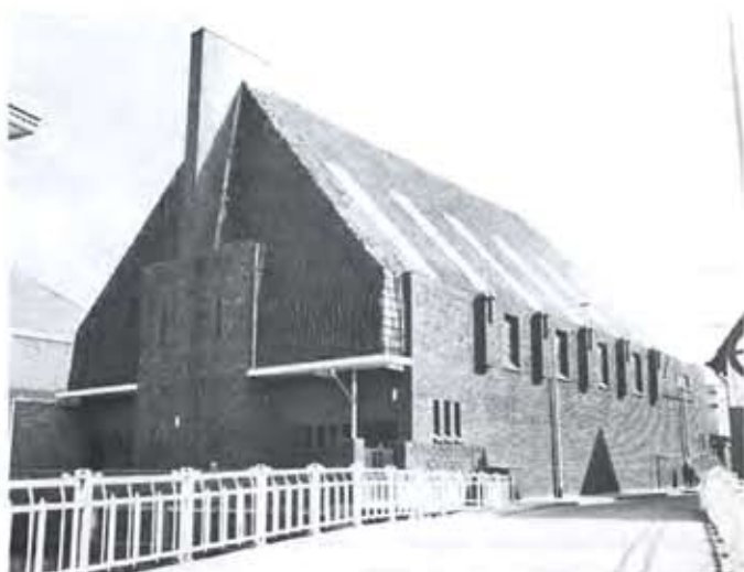
17. Achter- en zijgevel van de kerk in Appingedam. Het licht valt voornamelijk door de glaspanelen in het dak naar binnen. Zie ook afb. 12.
