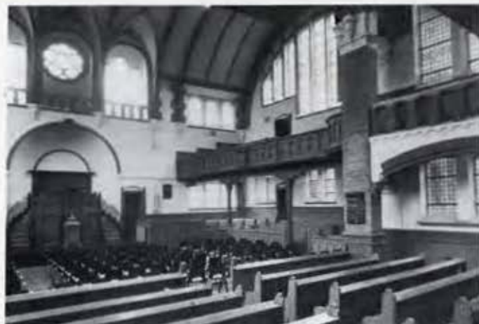
36. Interieur van de Zuiderkerk in 1981. Let op de afwisseling van schoon en gepleisterd metselwerk.
